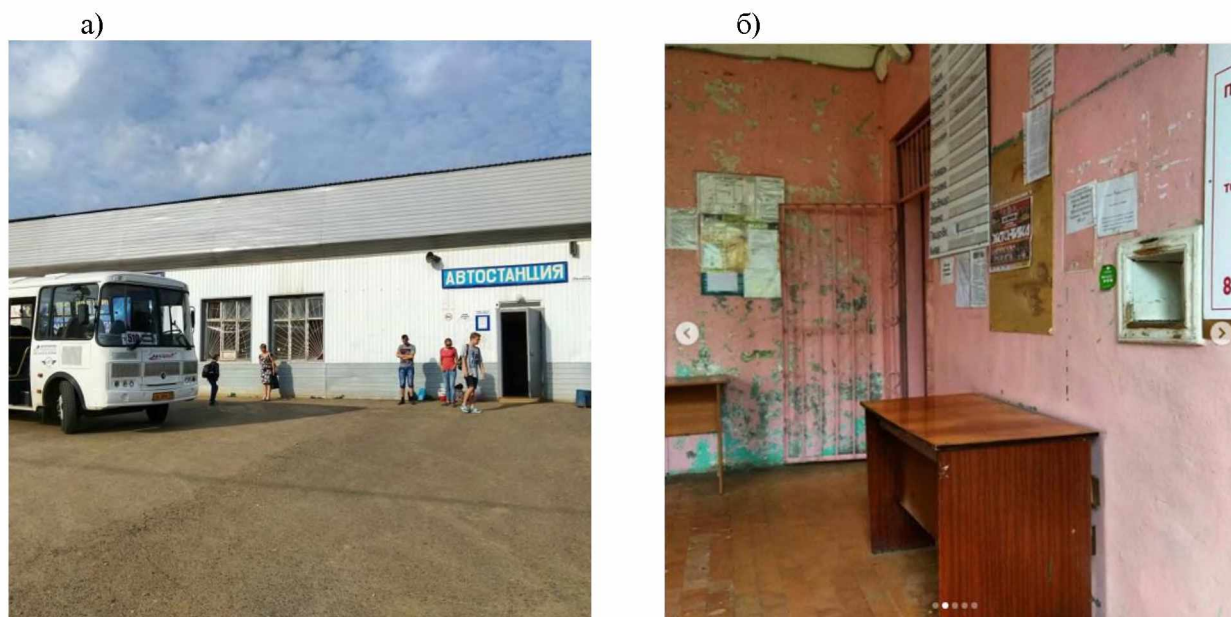
Рис. 2.3.4.1. Автостанция Шаркан: территория возле входа в автостанцию (а); помещение автостанции (б)
